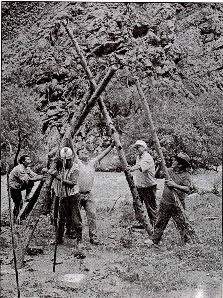
FOTO: CEDRUM/ Churín (Reparación de postes de luz)
